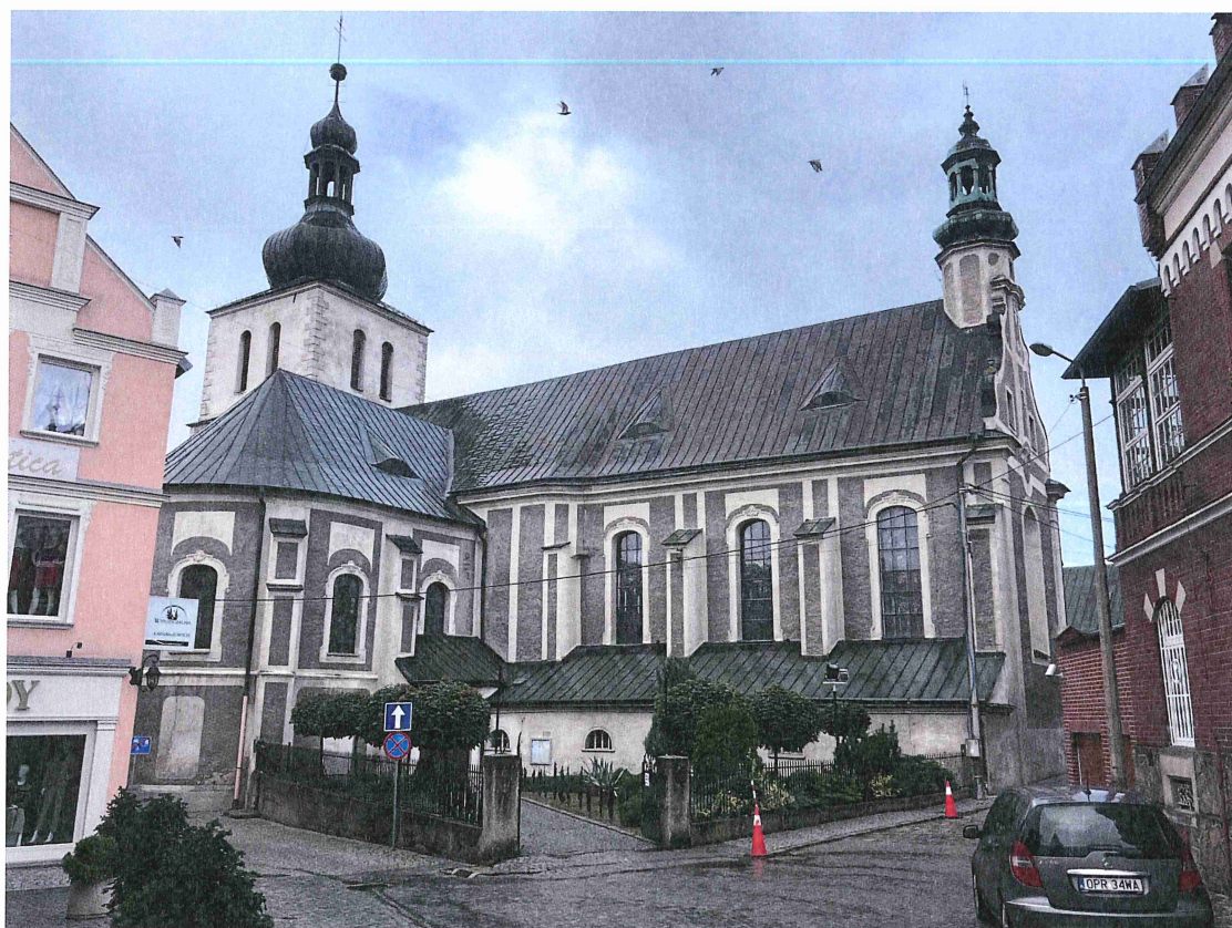
Fot. nr 6 Kościół p.w. św. Franciszka z Asyżu w Głogówku. Zespół klasztorny o.o. Franciszkanów. Widok od strony południowo-zachodniej. Fot. nr 7 Kościół p.w. św. Franciszka z Asyżu w Głogówku. Zespół klasztorny o.o. Franciszkanów. Widok od strony południowo-wschodniej.
