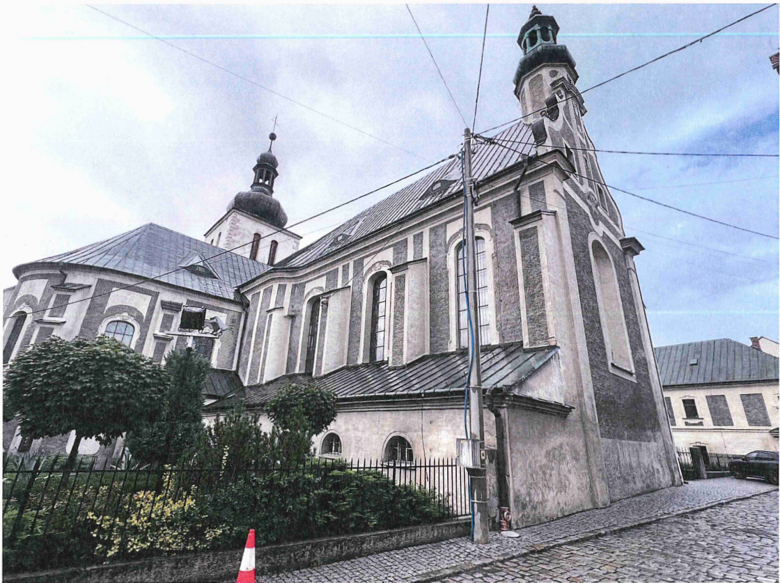
Fot. nr 4 Kościół p.w. św. Franciszka z Asyżu w Głogówku. Zespół klasztorny o.o. Franciszkanów. Widok od strony południowej. Fot. nr 5 Kościół p.w. św. Franciszka z Asyżu w Głogówku. Zespół klasztorny o.o. Franciszkanów. Widok od strony południowo-wschodniej.
